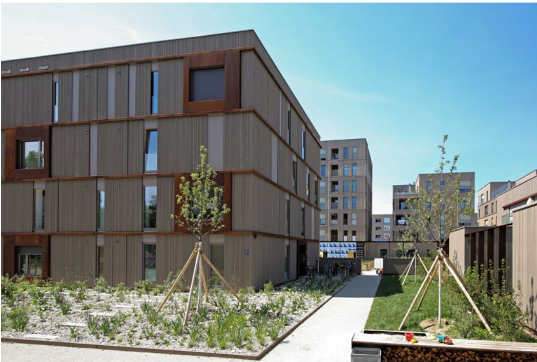
Gebäudegruppen des Prinz-Eugen-Parks in Holz- und Holz-Hybridbauweise. (Foto: Michael Nagy, LHM)
