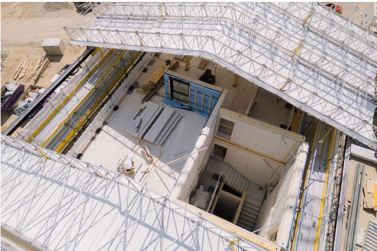
Blick von oben auf eines der im Bau befindlichen Häuser in Immendingen. Der Witterungsschutz erfolgt mit einem fahrbarem Gerüstdach. (Foto: GROPYUS AG)
